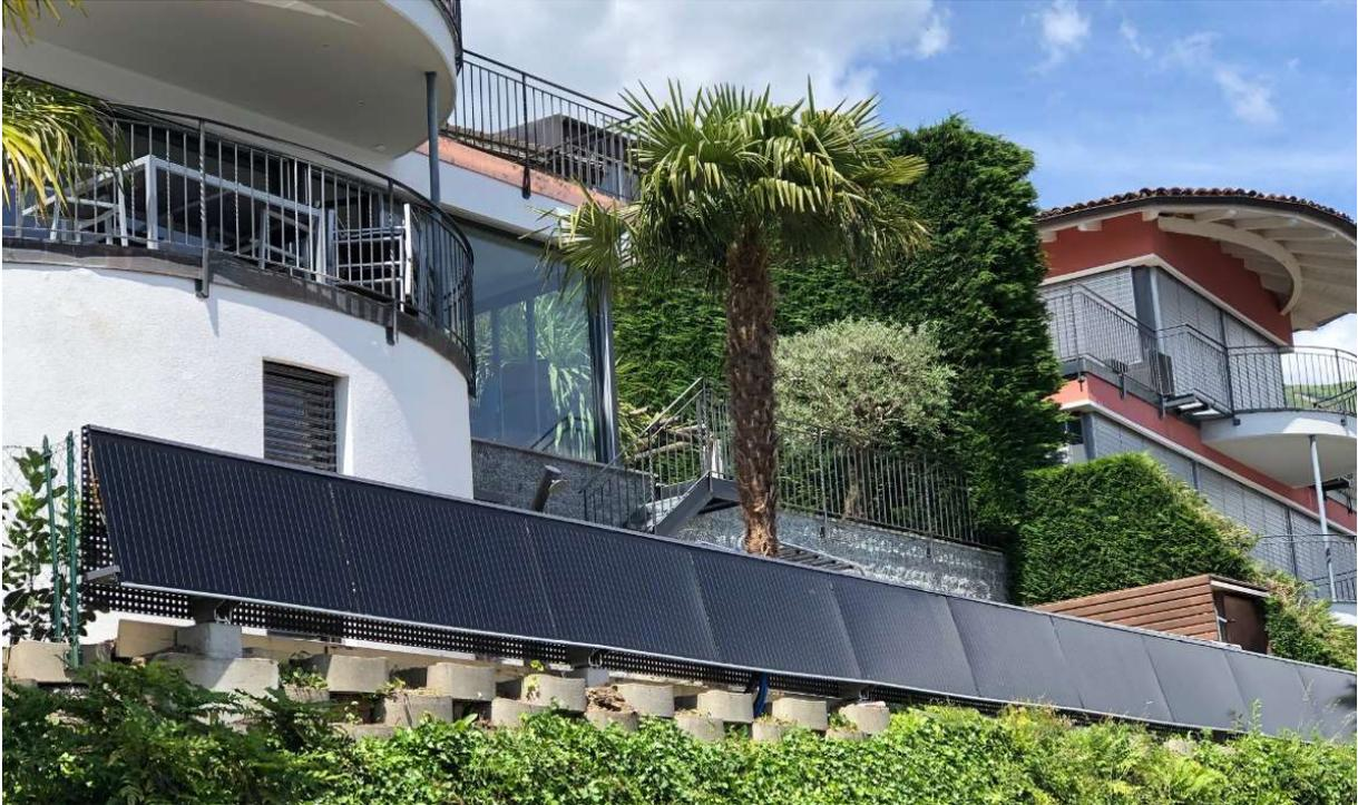
Die 10 Hybridmodule haben eine installierte Gesamt-Leistung von 7,5 kWp thermisch und 2.5 kWp elektrisch.
